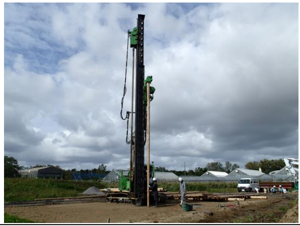
【軟弱地盤対策の実験】 様々な地盤で軟弱地盤対策の実験を実施しました 4) 。
